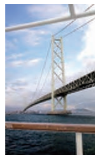
図1 明石海峡大橋
